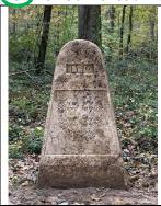
Cette borne avait été déterrée et couchée sur le sol. Elle a fait l'objet d'une remise en place lors de la campagne de redressement des bornes en novembre 2023. Sa position a préalablement été définie par un géomètre en prenant en compte les autres bornes. On voit bien l'alignement de ces deux bornes qui sont visibles de l'une à l'autre.
